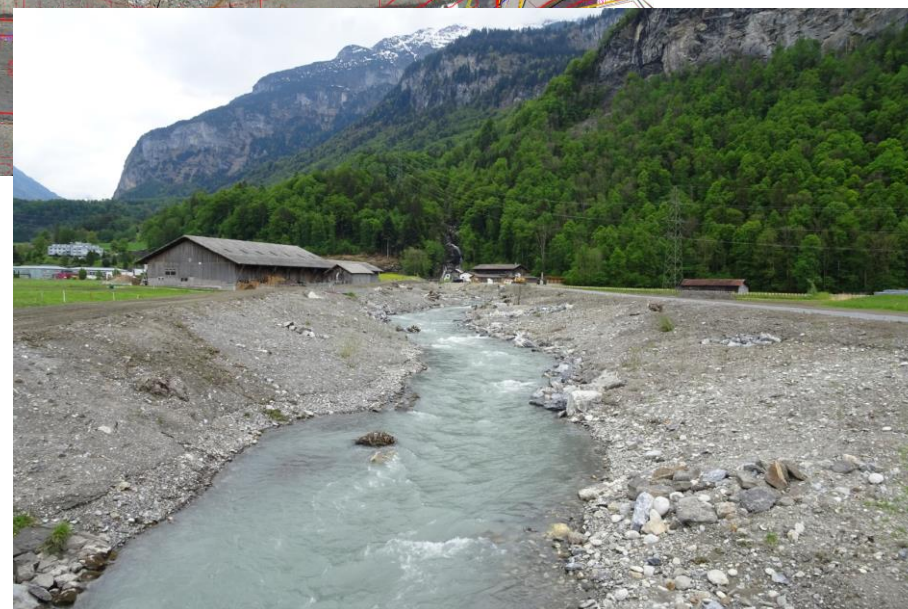
Abb. 12: Blick von Reichenbachbrücke bachaufwärts mit der frisch realisierten Renaturierung Baulos 1
