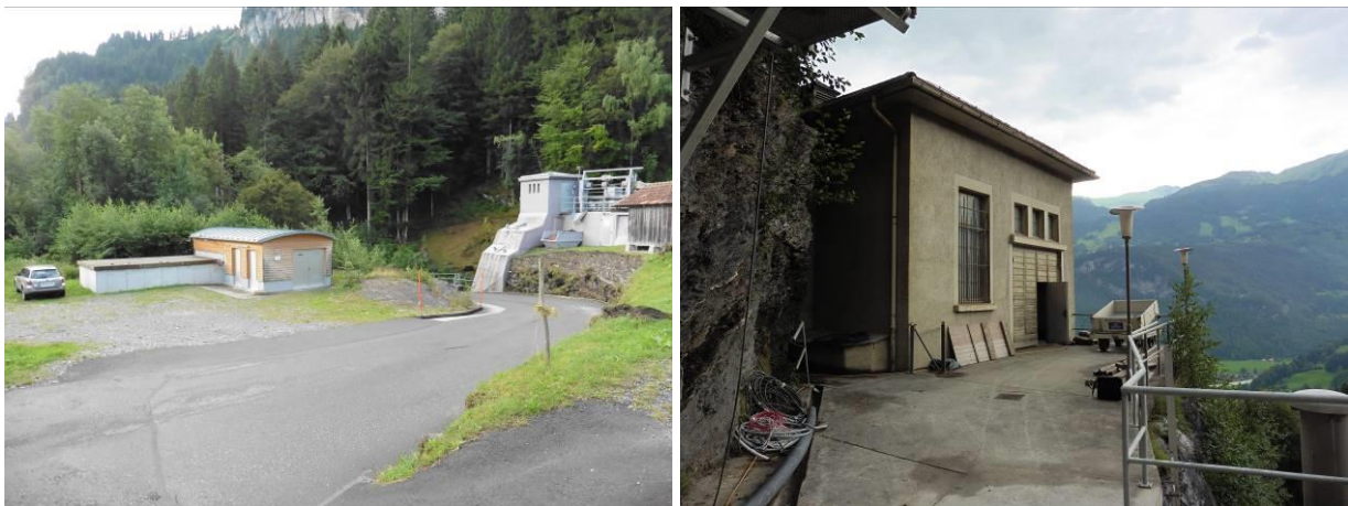
Abbildung 26: Installations- und Umschlagplätze, Zwirgi (links) Zentrale SH2 (rechts)
