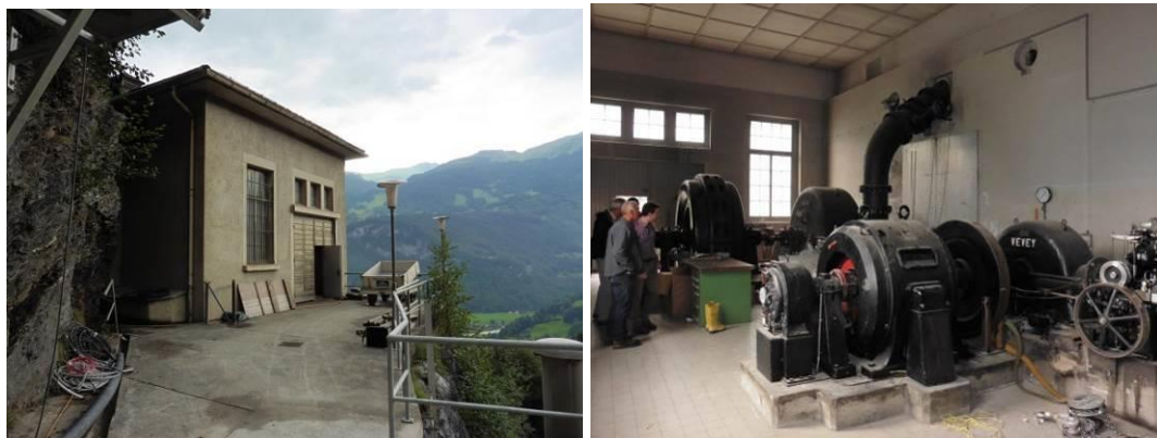
Abbildung 16: links = Südostfassade des Zentralgebäudes, rechts = Maschinensaal mit den beiden Maschinengruppen
