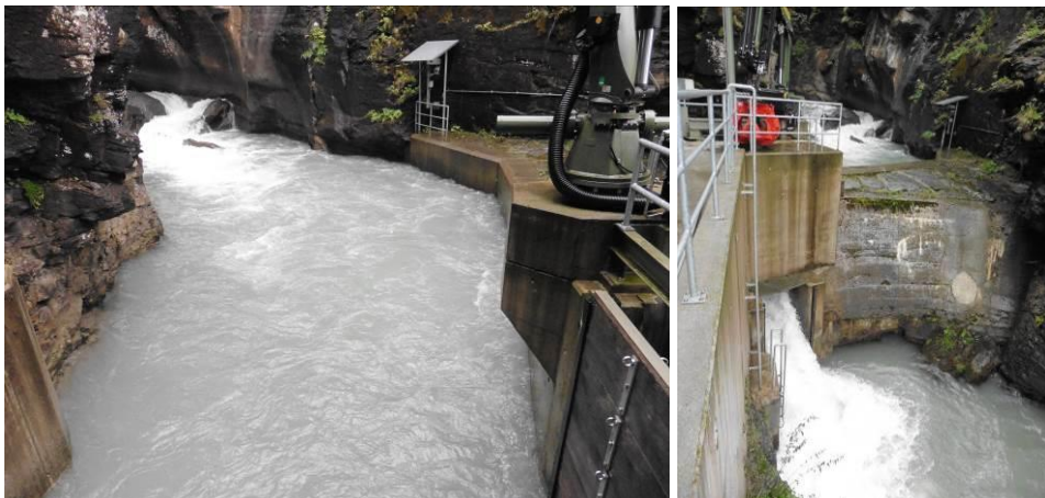
Abbildung 17: Vorstau (links) und Überleitung in Stauweiher Zwirgi (rechts)
